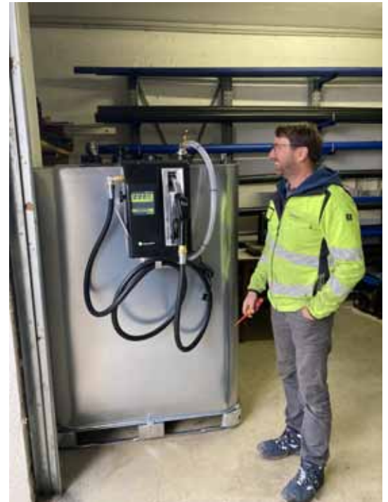
Wassermeister Robert Sudy vor dem neuen Tank mit 1000 Liter Diesel für das Notstromaggregat.
